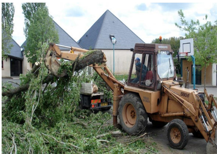
Début des travaux dans les cours d'école
