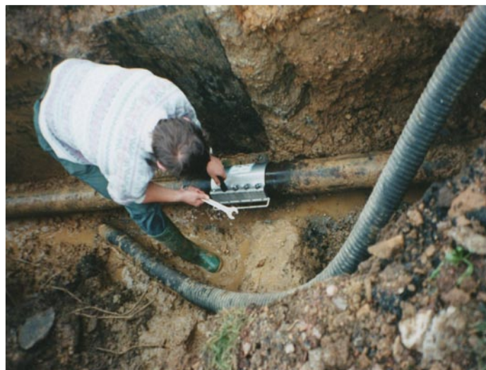
Réparation d'une fuite d'eau
